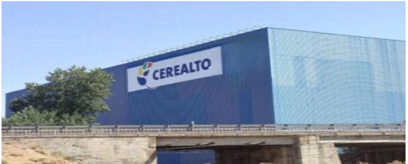
Almacén Automático de Cerealto en Venta de Baños, Palencia
